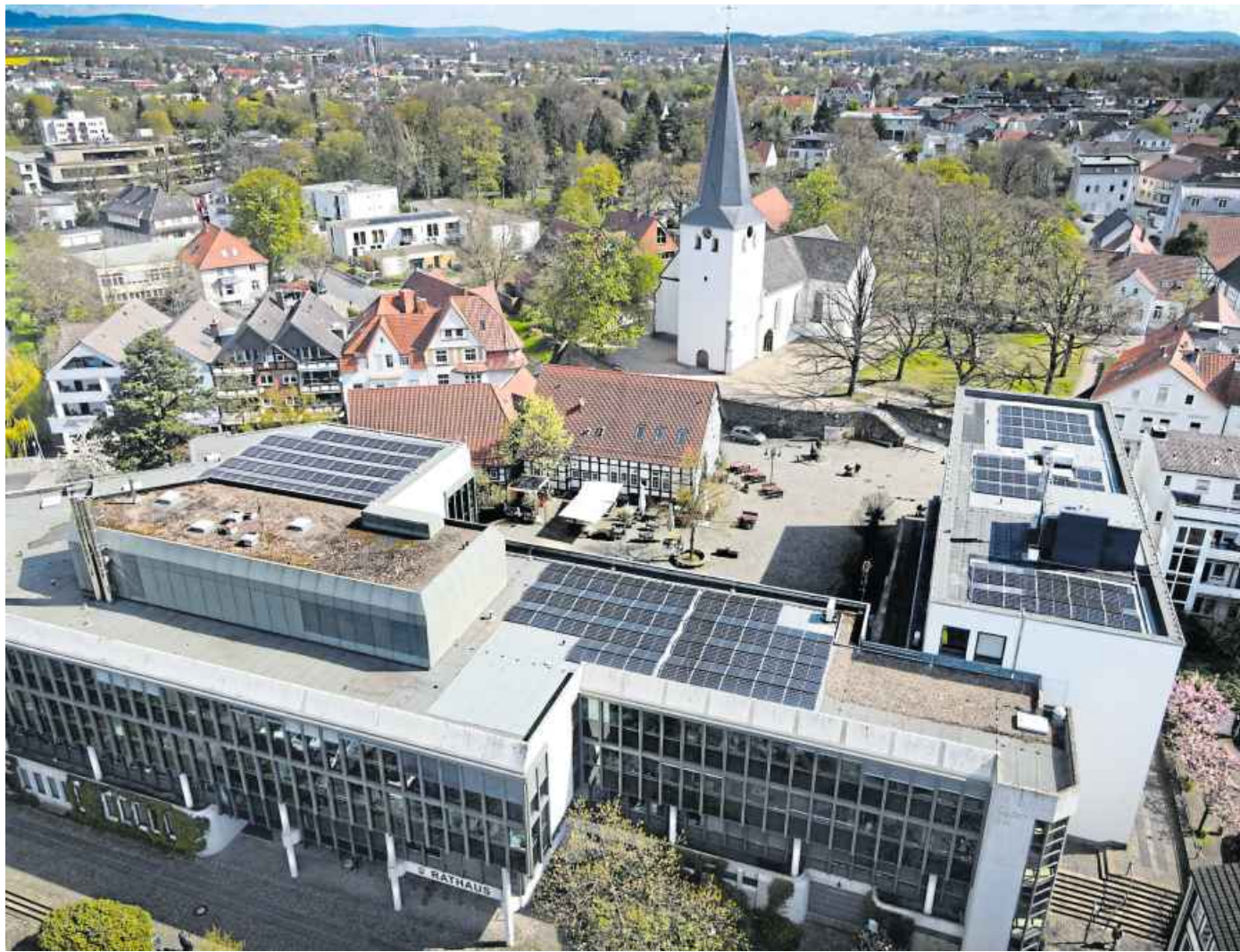
Das Bündler Rathaus wurde 2023 mit einer Photovoltaikanlage ausgestattet.
